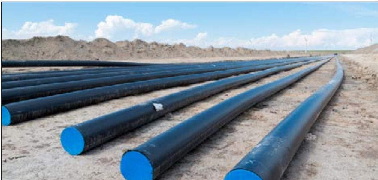
Tuberías para los cables de alta tensión de aerogeneradores terrestres
