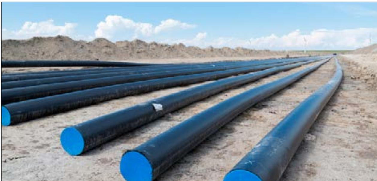
Кабелепроводы высоковольтных кабелей для наземных ветряных турбин
