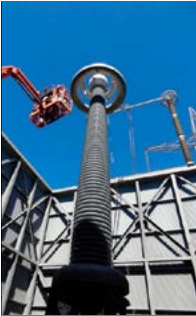
Raccordement du câble de mesure à une hauteur vertigineuse
