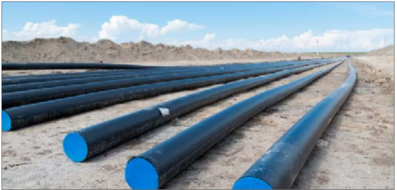
Conduits de câble pour des câbles haute tension d'éoliennes terrestres
