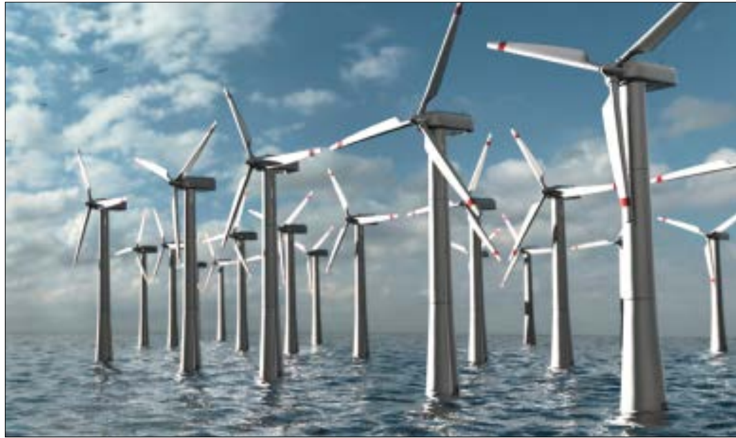
Les câbles transportant le courant des parcs éoliens offshore à la terre doivent aujourd'hui transporter de grandes quantités d'énergie. Ici aussi, il est judicieux d'avoir à disposition l'équipement adapté pour la localisation des défauts de câble pour le pire des cas
