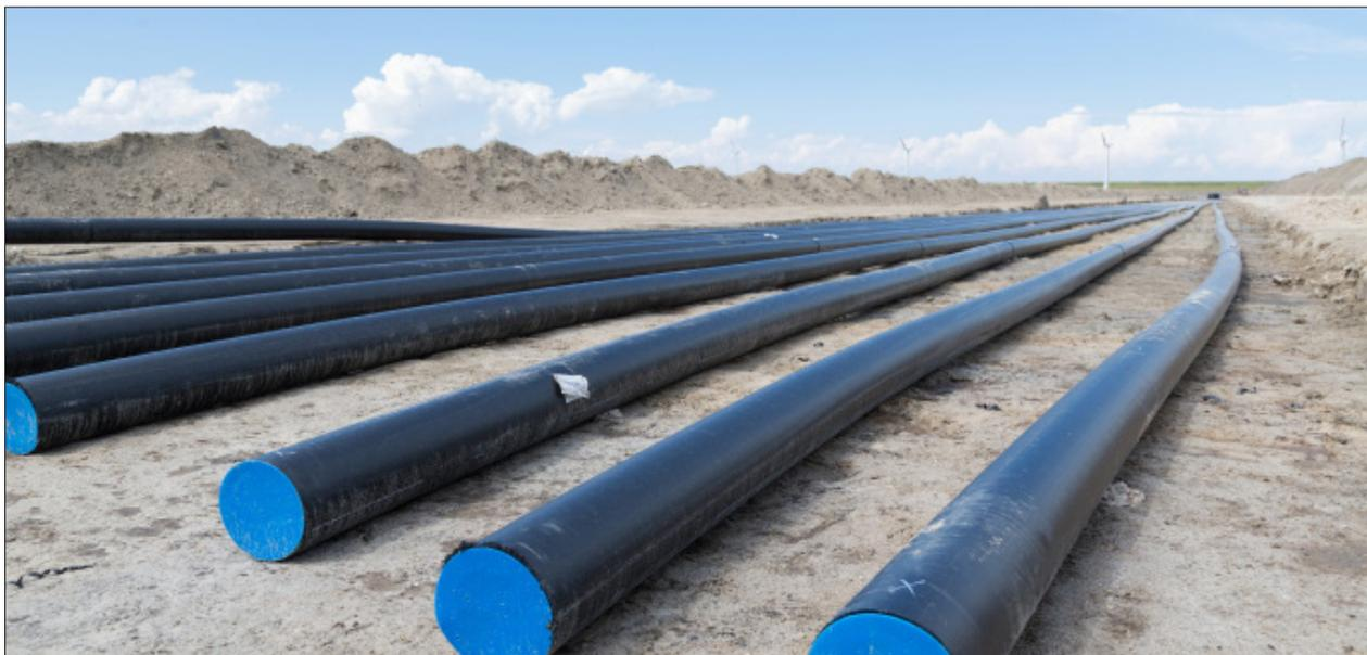
用于陆上风力涡轮机高压电缆的电缆管道
