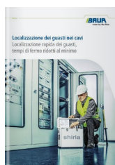
Localizzazione dei guasti nei cavi
