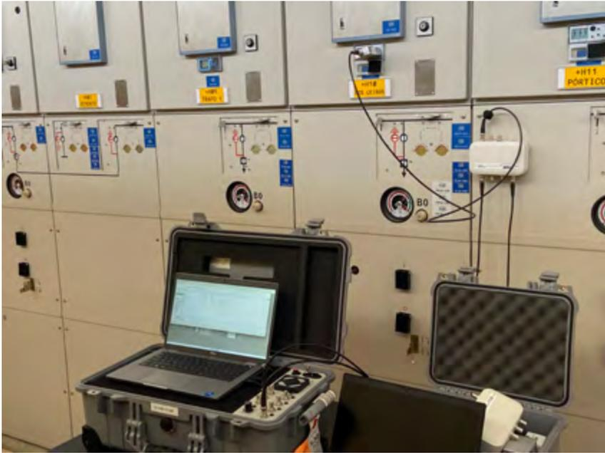
Figure 5. Les séquences de mesure automatisées et le support logiciel pour l'évaluation permettent d'effectuer la mesure des décharges partielles en ligne en quelques minutes.
