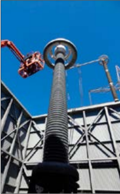
Collegamento del cavo di misura a un'altezza da capogiro
