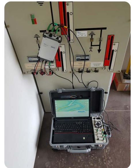
在通电状态下连接, 在通电状态下测量: 通过 VDS-C 可在运行时快速而便捷地检测电缆的局 部放电。
