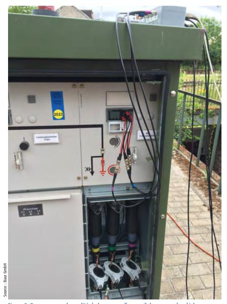
Figure 3. Pour comparer la qualité de la mesure, l'appareil de mesure des décharges partielles liona a été raccordé aussi bien avec le nouveau coupleur DP VDS (en haut) qu'avec la sonde HFCT (en bas).
