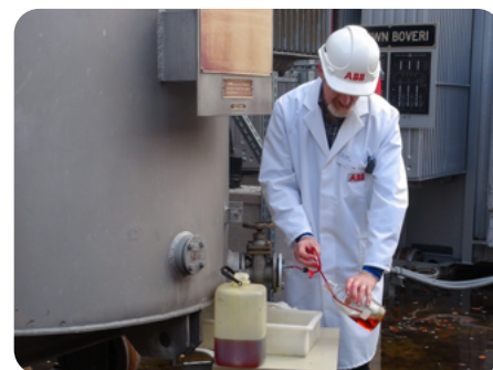
С помощью приборов BAUR Эрик Киллер, сотрудник ABB Sécheron AG измеряет электрическую пробивную прочность изоляционных масел, а также лабораторные показатели, позволяющие оценить состояние масла.
