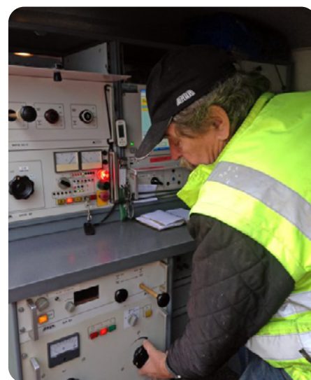
Willi Bohler —aquí en el vehículo de medición de cables— es técnico de medición en Gasenzer AG (distribuidor exclusivo de los equipos BAUR en Suiza y responsable aquí de la localización de averías en cables).
