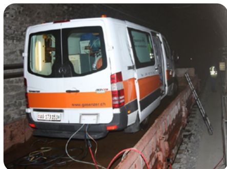
El vehículo de medición de cables de BAUR se transporta al túnel de Simplon con el tren de trabajos del servicio de obras (SBB).
