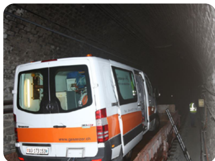
Le laboratoire mobile de maintenance des réseaux BAUR est acheminé dans le tunnel du Simplon à l'aide du train de travaux du service de construction des CFF.
