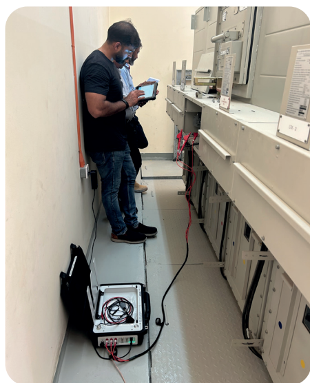
Mesures avec l'échomètre IRG 400 portable BAUR
