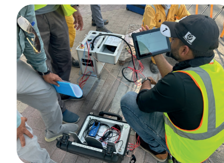
Localisation des défauts externe grâce à la méthode TDR-Ultra Fin
