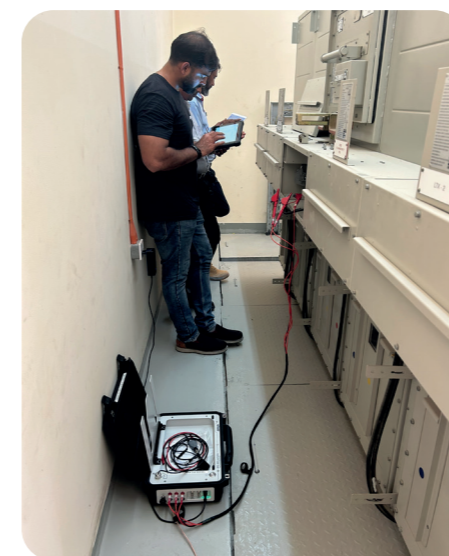
Medições com o reflectômetro de pulso IRG 400 portable da BAUR
