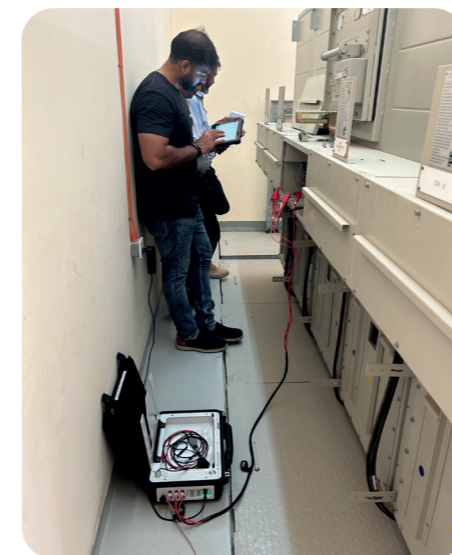
Измерения с помощью импульсного рефлектометра BAUR IRG 400 portable
